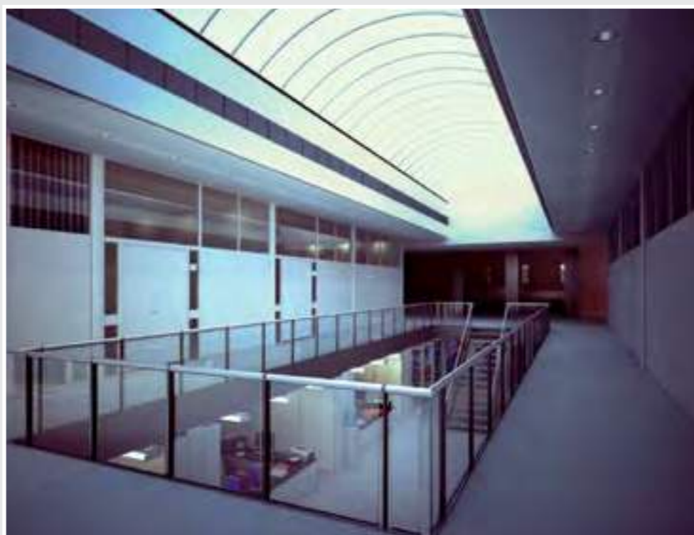
ACOPERIȘ CONTINUU Exemplu de luminator cu utilizarea de profile din aluminiu ranforsat
